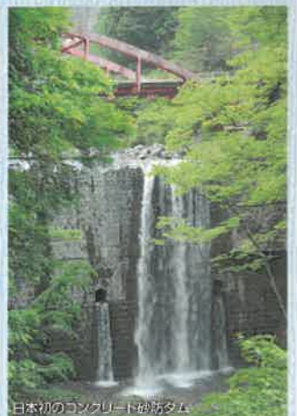
日本初のコンクリート造りダム
